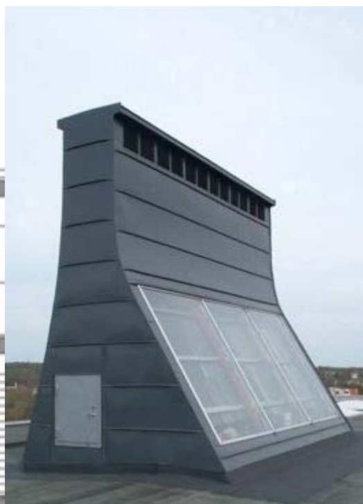
Chimenea solar con muro Trombe.
