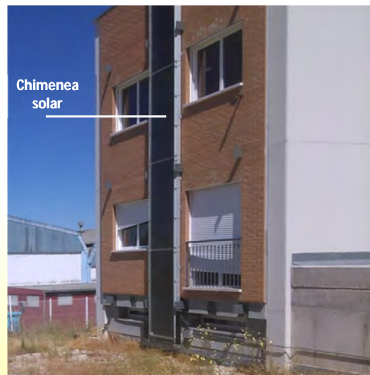
Chimenea solar en los Demostradores EDEA
